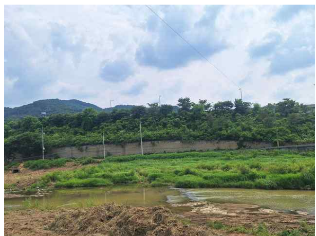
5공구 블럭식 옹벽 06
