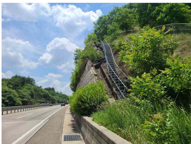
4공구 패널식 옹벽 05
