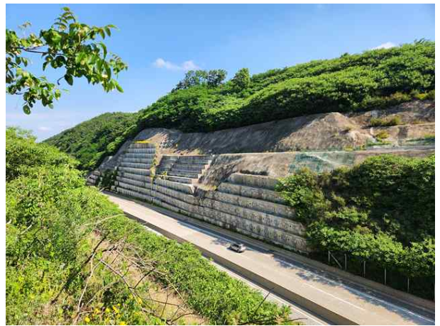
6공구 패널식 옹벽 10
