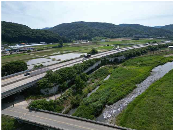
6공구 패널식 옹벽 07
