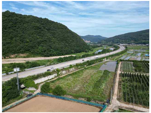
6공구 패널식 옹벽 08
