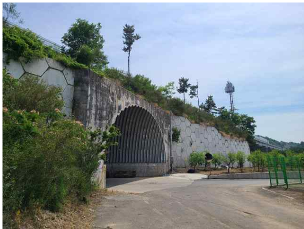
9공구 패널식 옹벽 15
