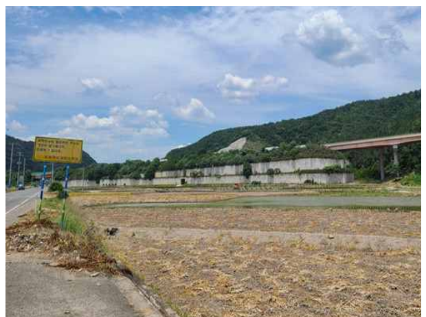
7공구 패널식 옹벽 12
