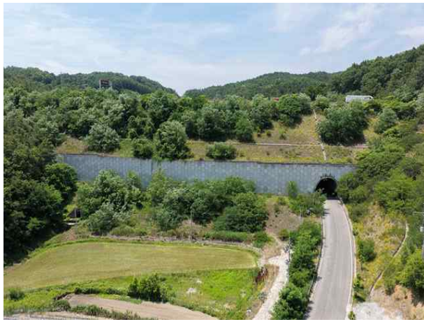
8공구 패널식 옹벽 13
