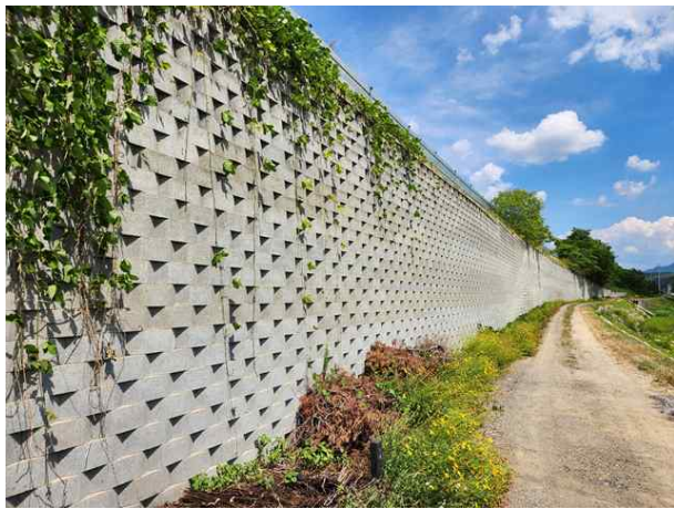
6공구 블럭식 옹벽 09
