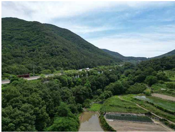
3공구 패널식 옹벽 01
