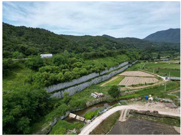
3공구 패널식 옹벽 02
