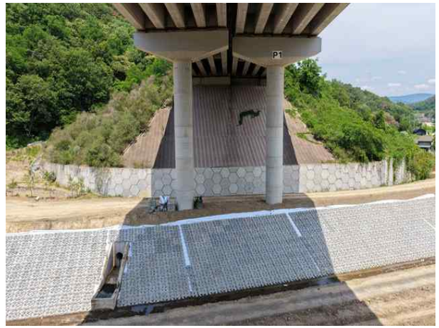
8공구 패널식 옹벽 14
