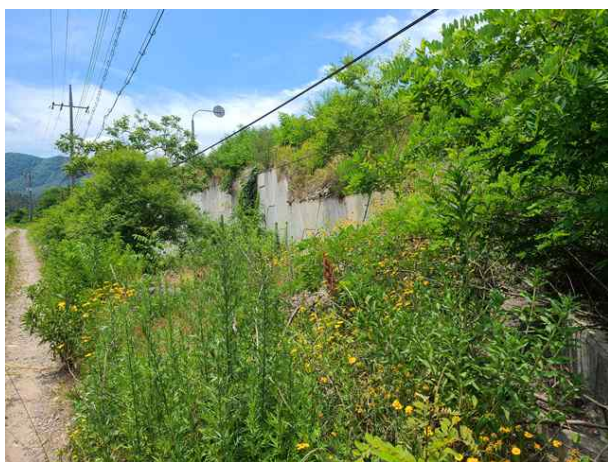
7공구 패널식 옹벽 11
