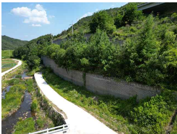
4공구 블럭식 옹벽 03
