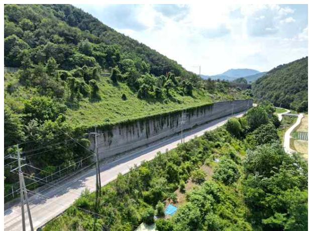
4공구 블럭식 옹벽 04
